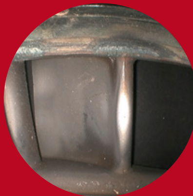
Grieta de una boquilla en una turbina (espacio aéreo)
